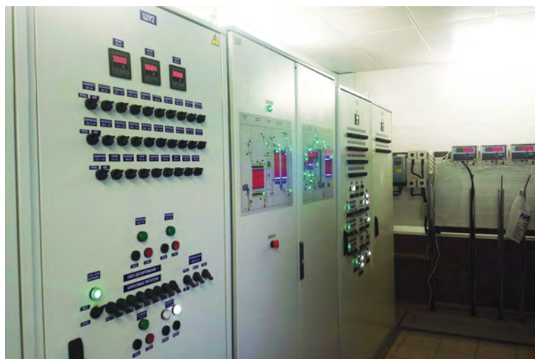
Рисунок 8. Операторская блочно-модульного комбикормового завода
