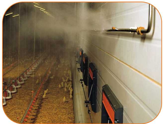
РИСУНОК 2. СИСТЕМА ФОРСУНОЧНОГО ТИПА
